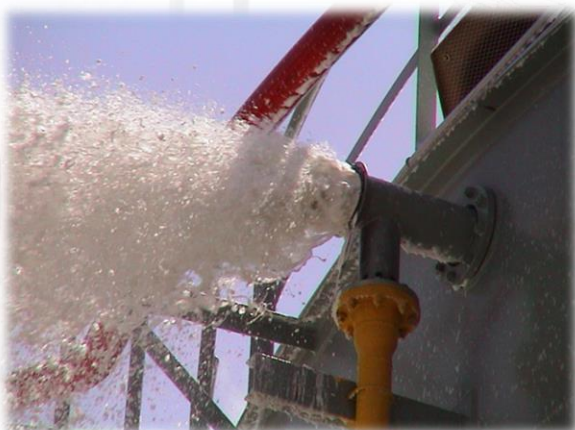
Wylot testowy piany.
